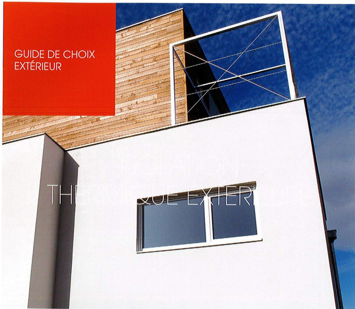
L'Isolation Thermique Exterieur est une technique constructive reconnue et de plus en plus utilisée par les maîtres d'œuvre. Dans un contexte exigeant, les solutions recherchées répondent à des exigences complexes et variées. Avec des technologies d'enduits de base organiques ou minérales (base ciment), les systèmes d'enduit mince sur isolant Seigneurie® proposent une gamme d'esthétiques multiples avec des produits à base organosiloxane ou silicate très performants.
